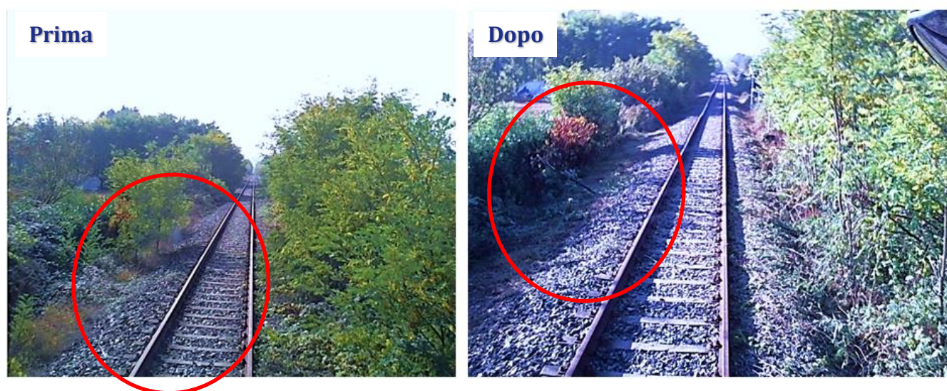
Figura 1. Esempio di immagine che mostra l'individuazione della vegetazione interferente (Prima) che può limitare la percorribilità dei sentieri da parte del personale ferroviario addetto all'ispezione e alla manutenzione delle linee ed alla sicurezza dei convogli (intervento, Dopo).
